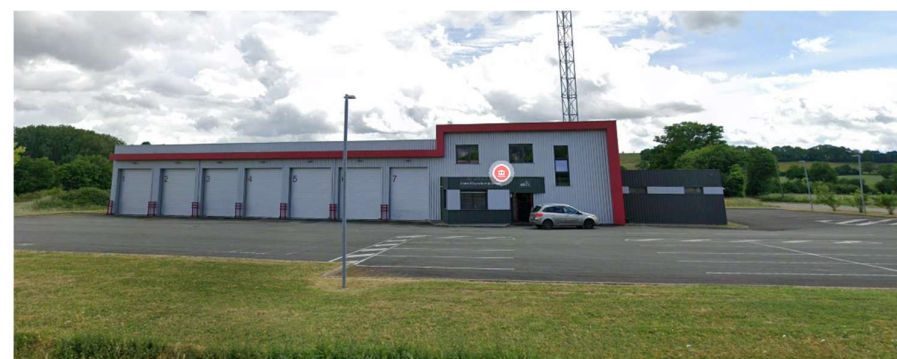
Centre de secours à Saint-Rémy-de-Sillé – Google Maps
