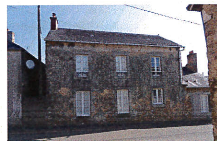
Venelle bouchée par un mur
