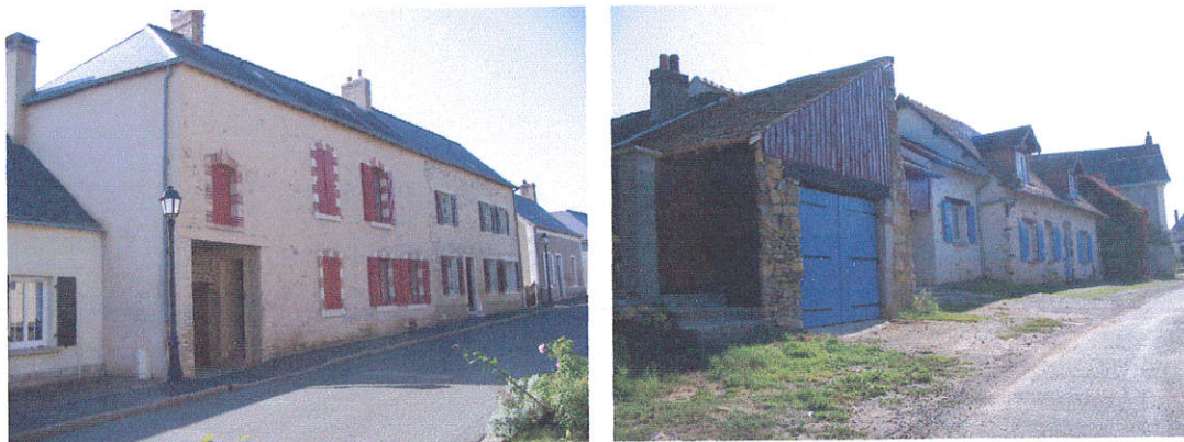
Vues de quelques fa  ades « restaur  es »
